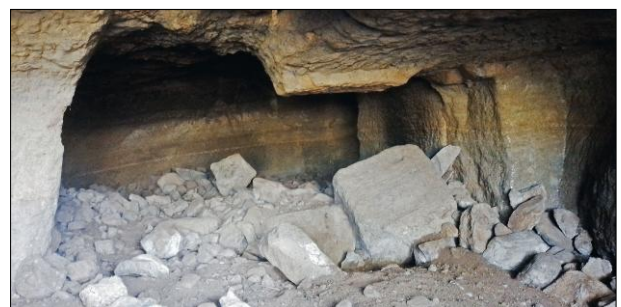
Partie exploitée avec de nombreux blocs tombés du plafond de la galerie
