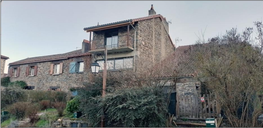
Maisons du lotissement du Grand-Jardin sur la commune de Saint-Cirgues construites avec des pierres extraites de la carrière du rocher de Lisoul
