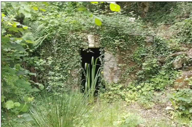
Le captage de la source « La Souveraine »
